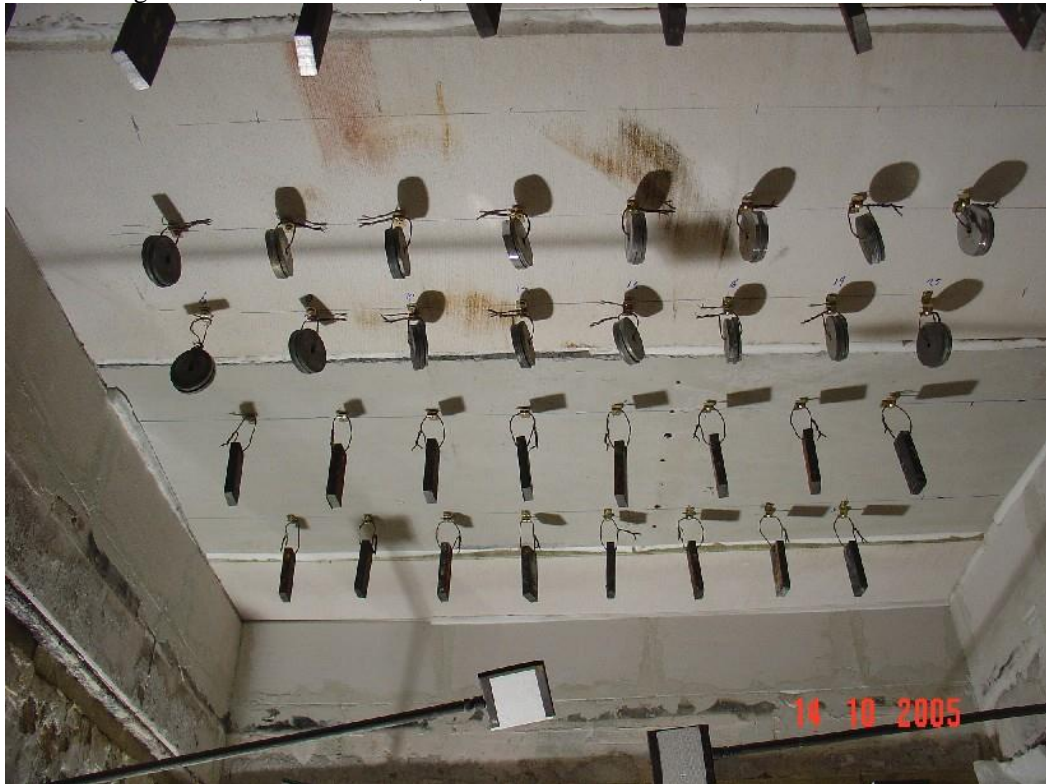
Foto 4: Beugels aan kanaalplaat en cellenbeton.
