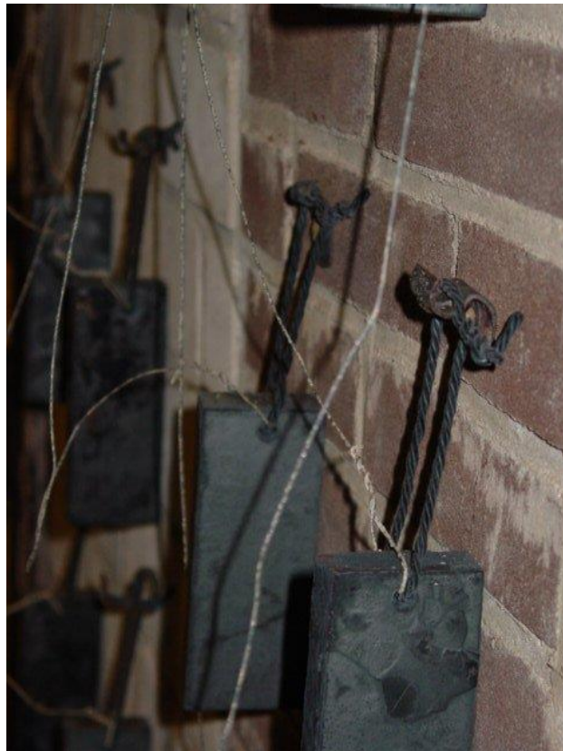
Foto 7: Vervormde beugels aan de wand.
