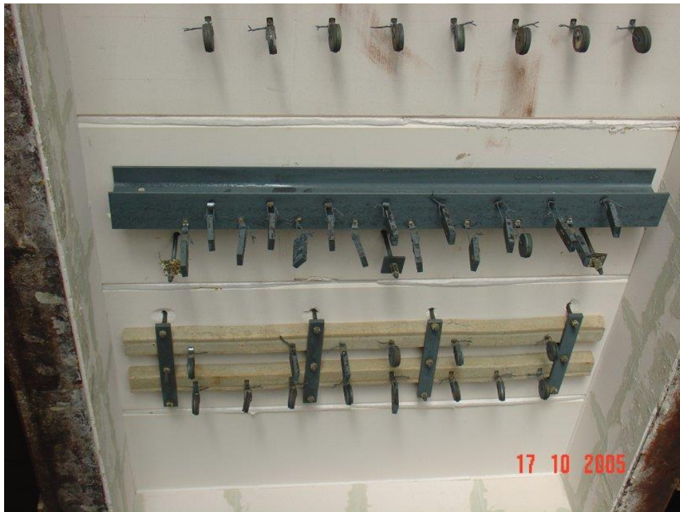
Foto 5: Beugels aan beton en staal na de test.
