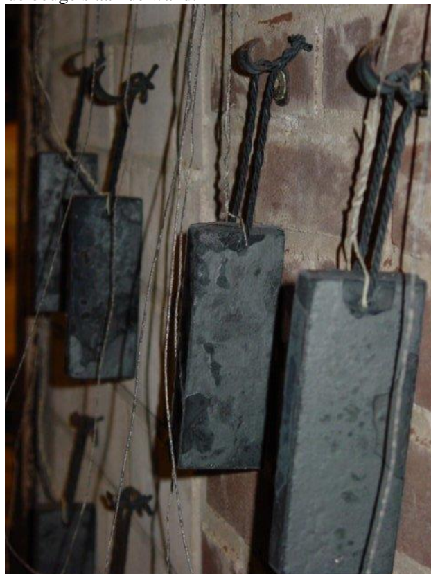
Foto 8: Bevestigingspunt onder de kabel waardoor gewicht is blijven hangen.
