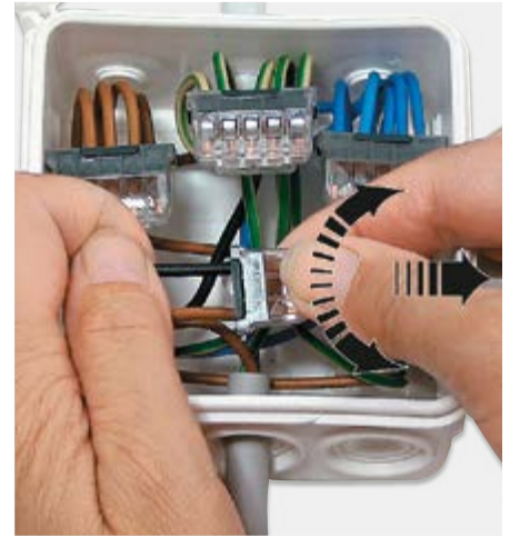
Lösen des Leiters durch Drehen und Ziehen Release the wire by twisting and pulling
