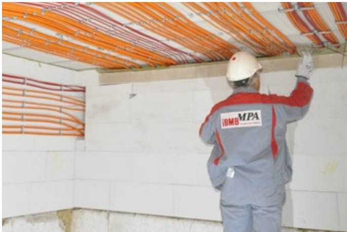
Installatie van de JMV beugels plus kabels in de testruimte van iBM.
